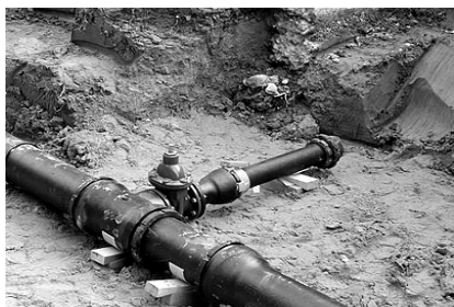
Obr. 1. Rozostavané odbočky na potrubí vodovodu ( foto: Jurík)
