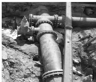
Obr. 1. Rozostavané odbočky na potrubí vodovodu ( foto: Jurík)
